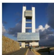
Torre de control
